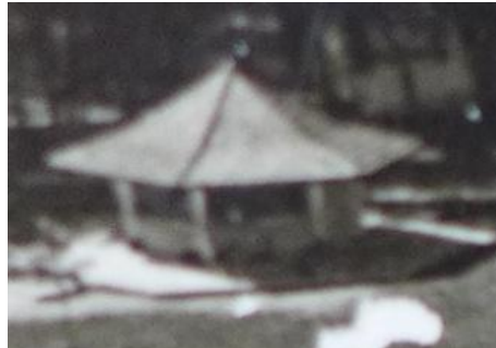
מסעדה שהוקמה סמוך לאגם, לכרם ולאמפי הפתוח בפארק הלאומי.
