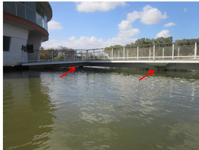
30. מבט מכיוון צפון על חיבור הגשר למבנה, ועל עמודי בטון מתחת לגשר
